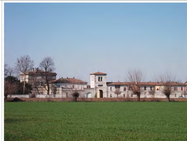
Villa Vegezzi – lato est
