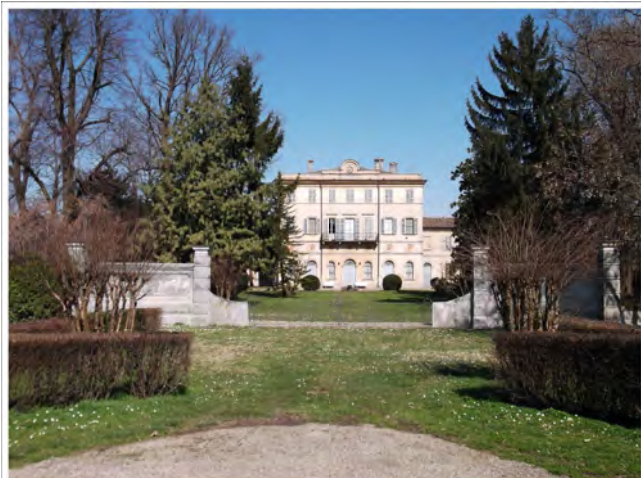
Villa Vegezzi - fronte
