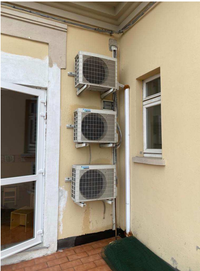
Figure 11 e 12: generatori per la climatizzazione estiva degli ambienti
