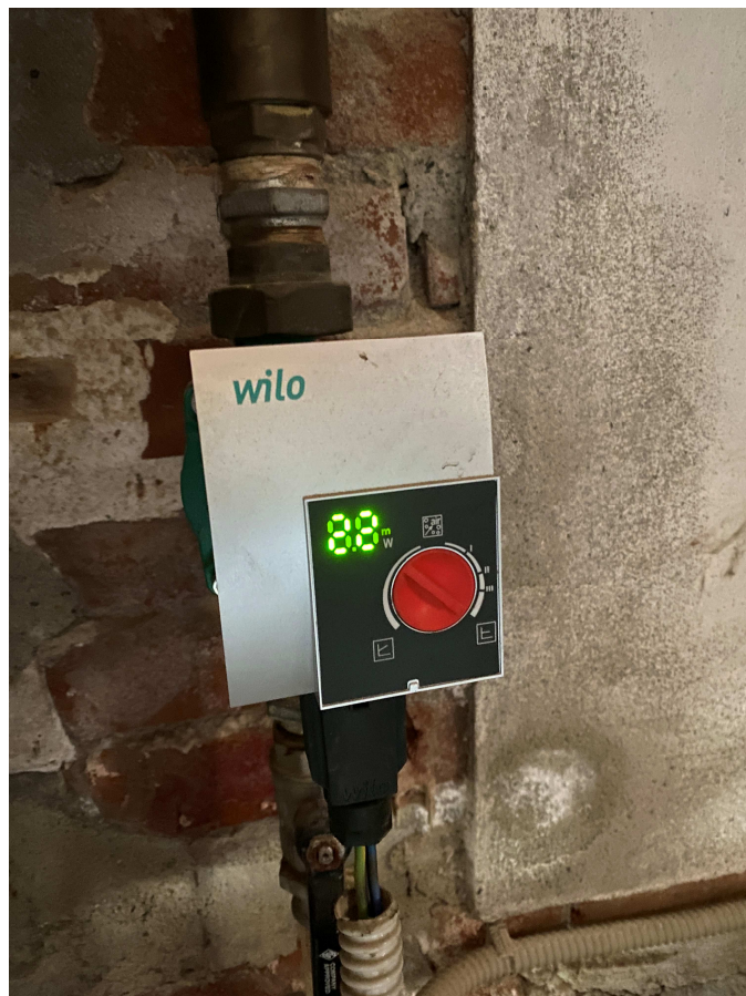
Figure 11 e 12: particolare del bollitore per la produzione di acqua calda sanitaria e pompa di circolazione
