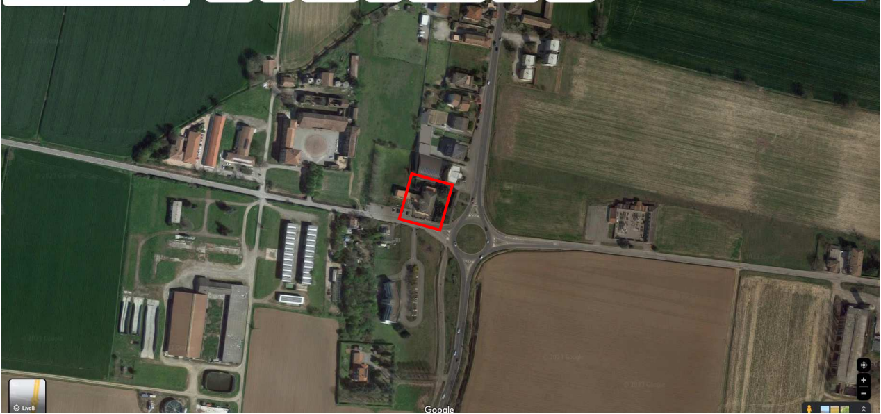
Figura 1: vista dall'alto dell'edificio
