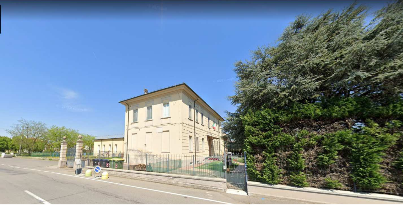
Figura 3: vista frontale dell'edificio
