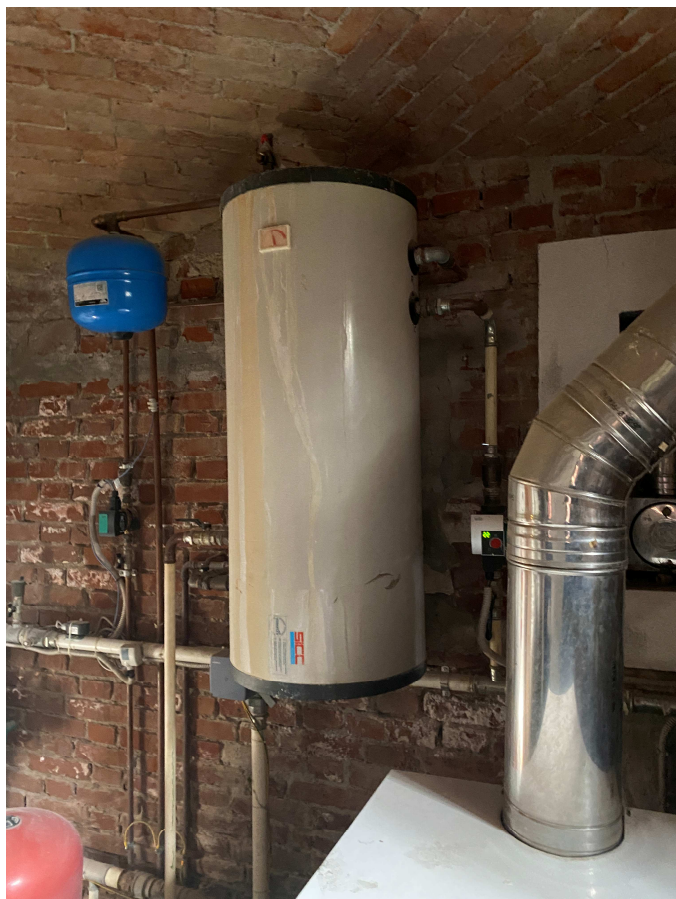
Figure 11 e 12: particolare del bollitore per la produzione di acqua calda sanitaria e pompa di circolazione
