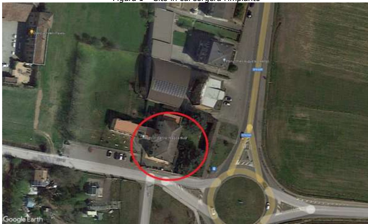
Figura 1 – Sito in cui sorgerà l'impianto
